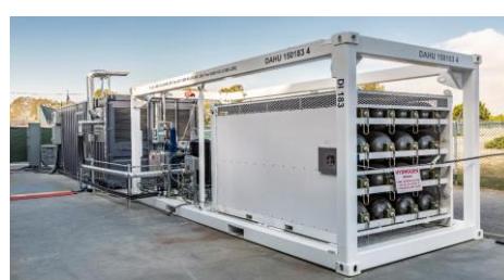
水素製造設備
